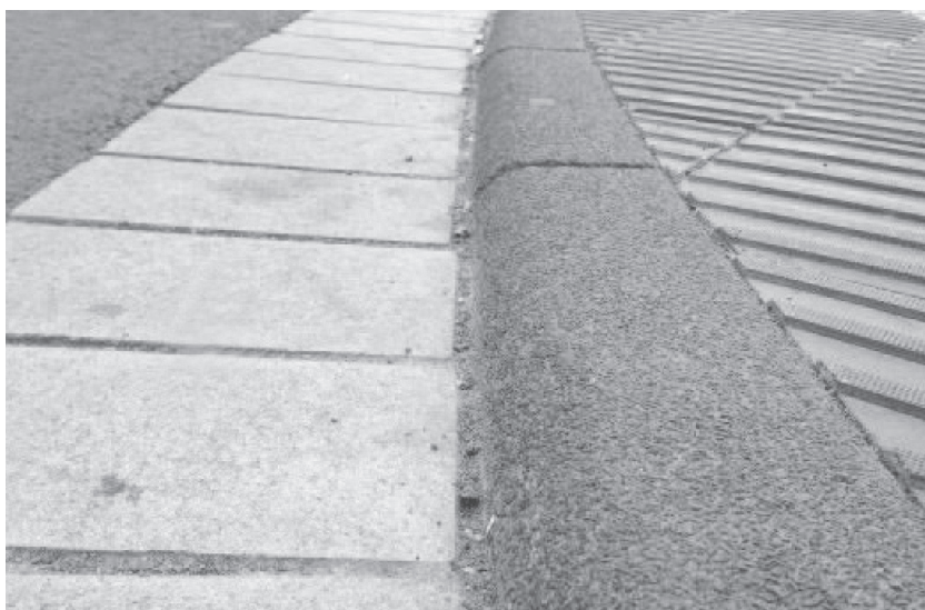
Überquerungsstelle mit einheitlicher Bordhöhe (Bild: Dirk Boenke, STUVA e. V., Köln)
